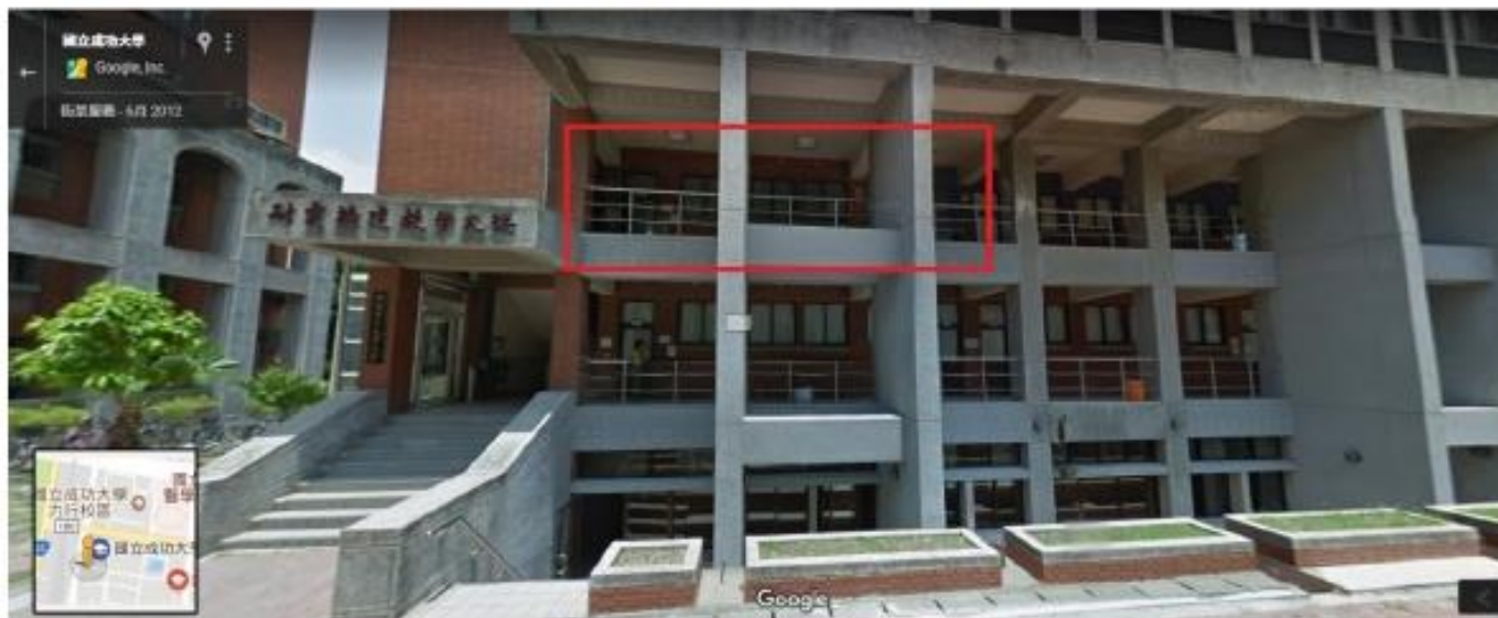
建築系 5127 教室：光復校區耐震大樓二樓(紅色框框)
